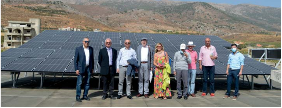
Offizielle Einweihung der Anlage, die nun die JLSS mit Strom versorgt.
